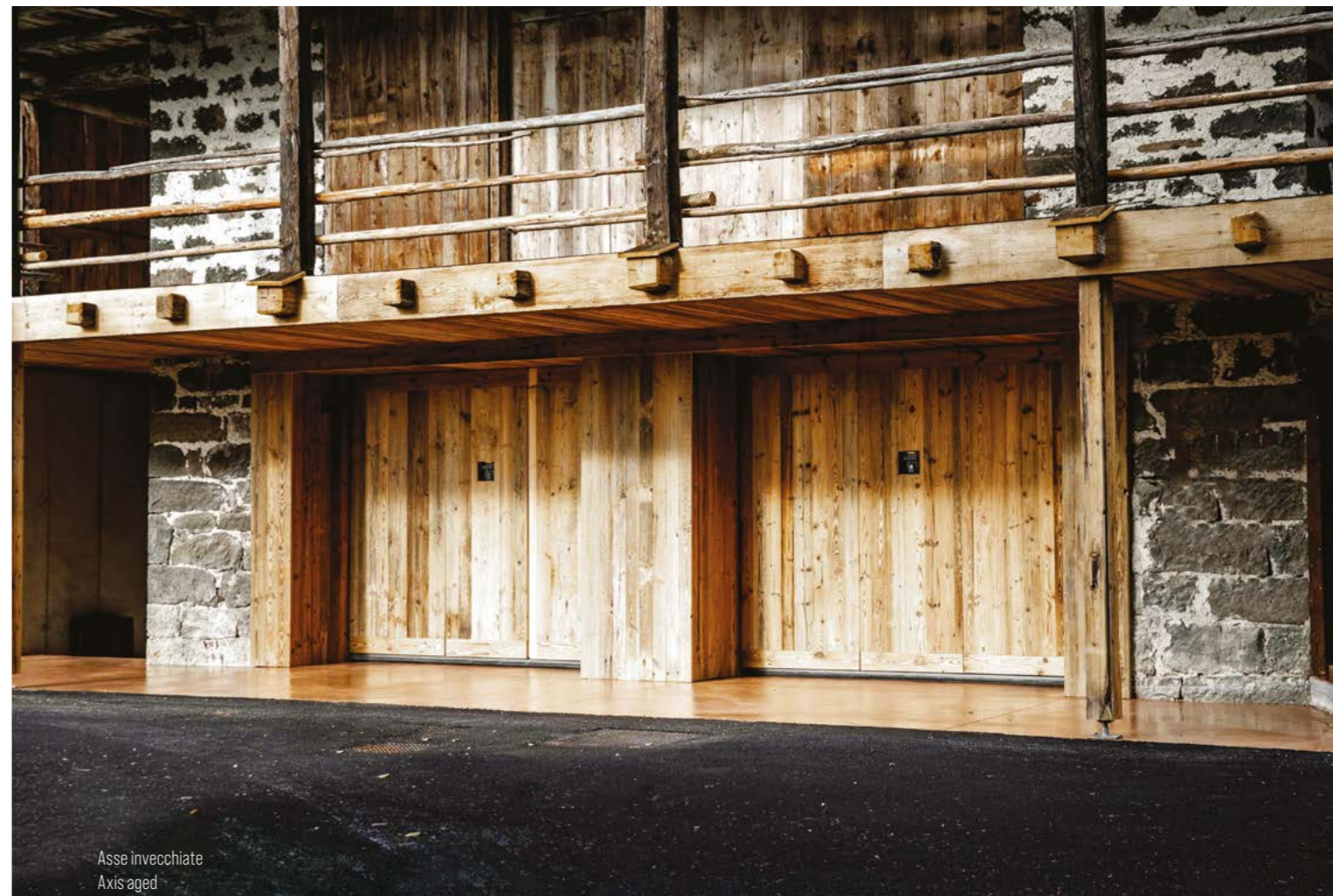
Soluzione filo muro con rivestimento in legno a facciata / Flush-to-wall solution with wooden facade cladding
